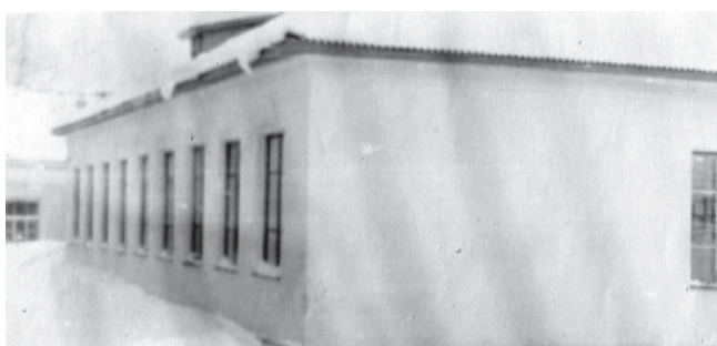
Новая пристройка к школе.
