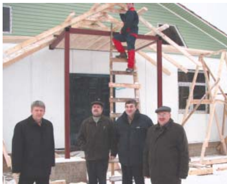
Оставшийся комплекс работ планируется завершить до 20 декабря.
