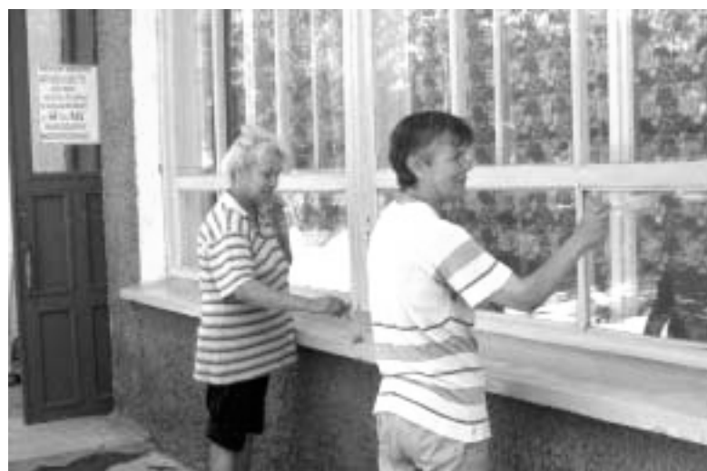
Последние штрихи. Ремонтные работы проводит ООО «Строитель».
